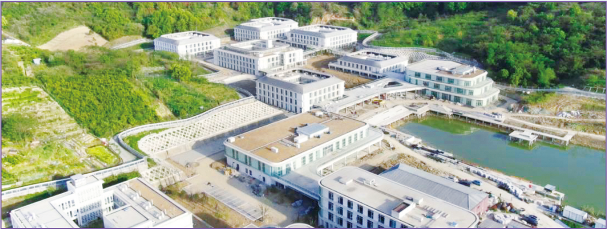
▲杭州市第一社会福利院迁建工程
